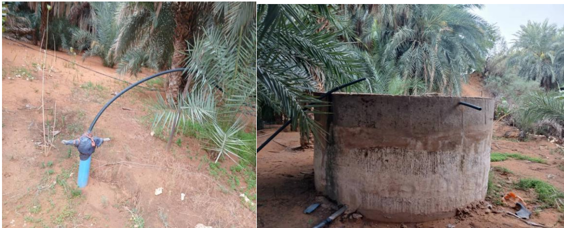
Les pompes manuelles devenues très répandues et bassin de réception et de distribution de l'eau
